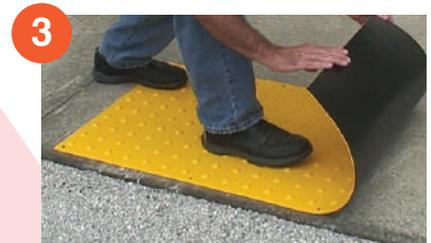
3 Presione la parte expuesta con adhesivo sobre la superficie. Mientras está parado en el extremo que se está adheriendo al concreto, retire las secciones restantes y presione la superficie completa.
