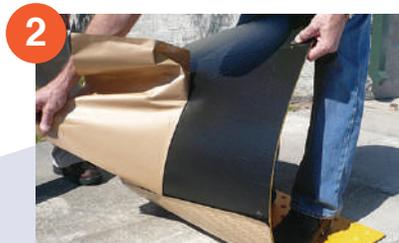
2 Usando el pie como apoyo sobre la palmeta para asegurar que no se mueva, retire una parte del papel protector.
