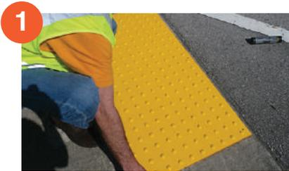
1 Después de garantizar que las condiciones detalladas anteriormente se hayan cumplido, y la superficie ha sido limpiada adecuadamente, coloque la(s) palmeta (s) en la posición deseada. Si se colocan uno al lado del otro, deje un espacio de 1/8 pulg entre ellos.
