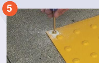
5 Asegúrese de que el tornillo y las arandelas estén orientados de manera que el cuello del tornillo caiga en el cono interior de la arandela. Con un destornillador, apriete los tornillos en los agujeros perforados. No apriete demasiado.
