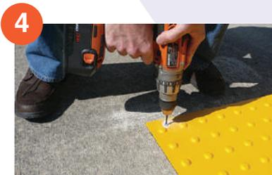
4 Taladre a través de los agujeros hechos anteriormente en el concreto hasta una profundidad de 1 1/4 pulg. perforado en el tapete 2 pulg. desde el borde lateral y 1 pulg. desde el borde biselado.
